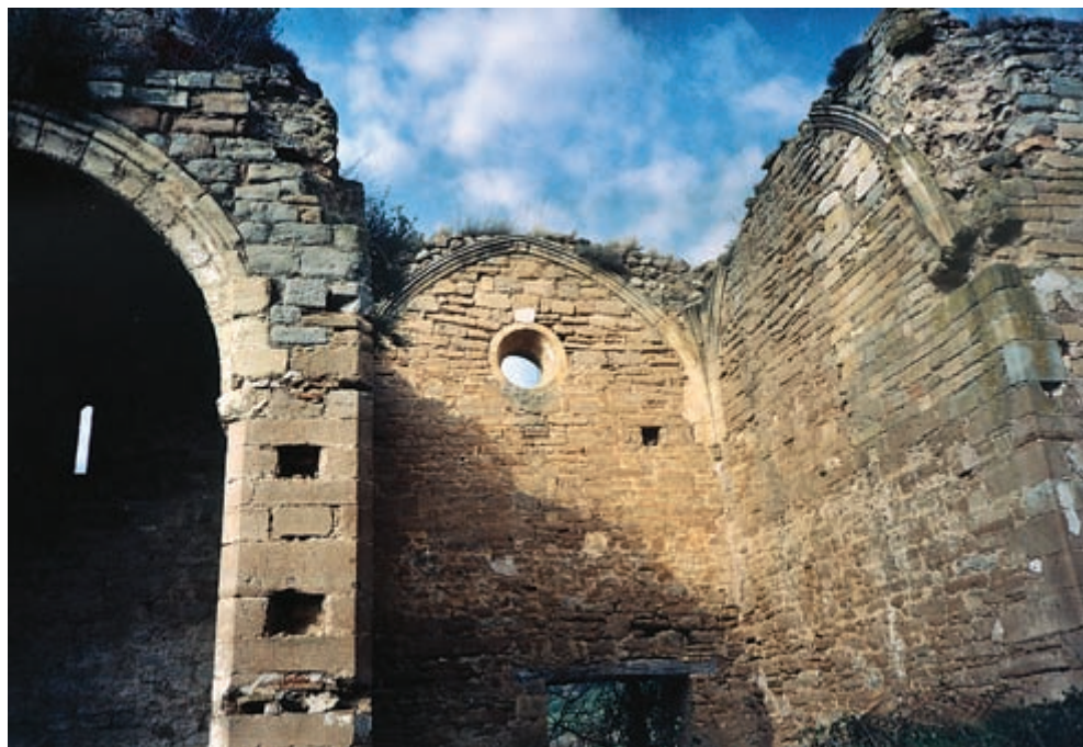
Interior del convento. Nave del crucero. Lado septentrional.
