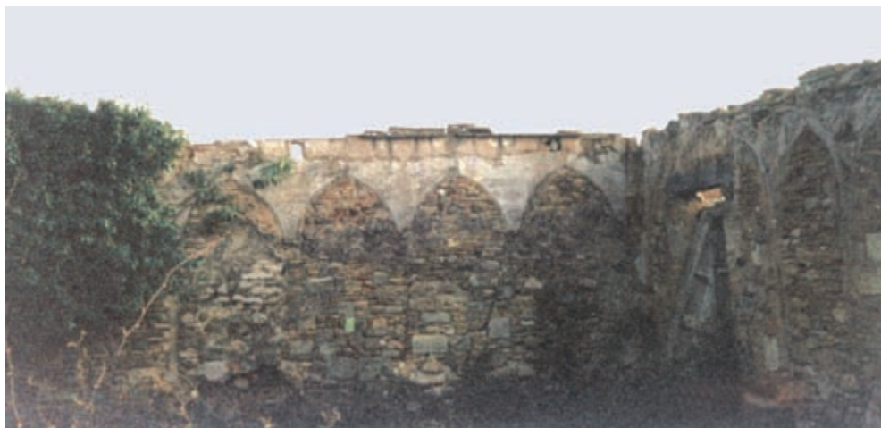
Vista interior de la fachada meridional del claustro.
