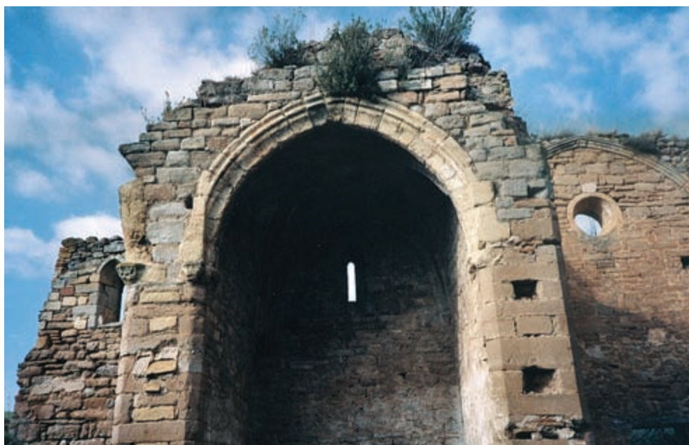
Estado actual de la primera capilla septentrional.
