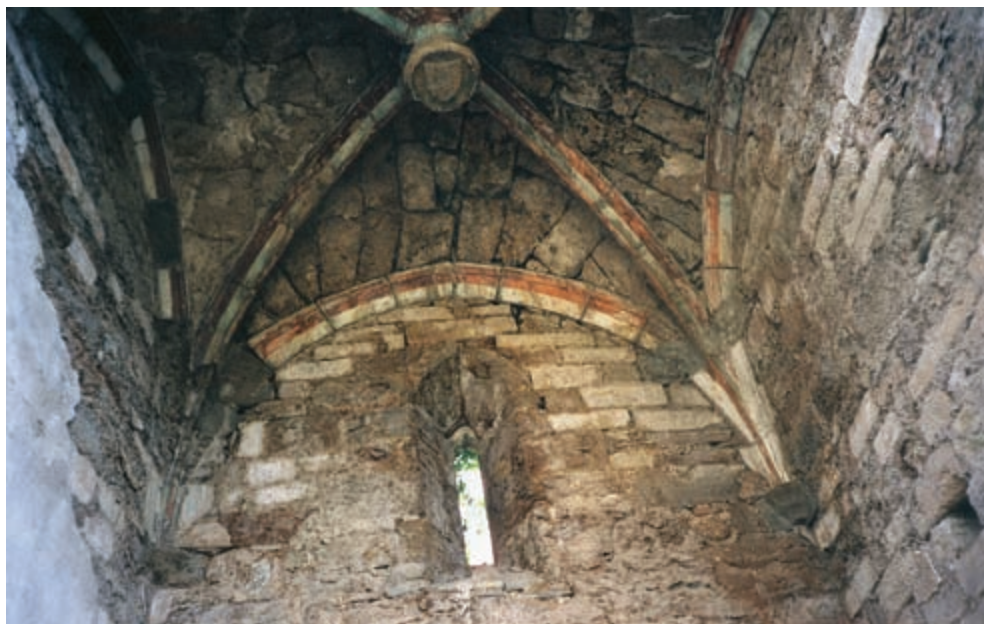
Bóveda de una de las capillas laterales.
