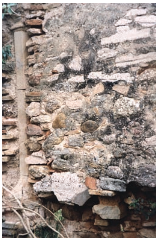
Detalle de una columna octogonal del claustro.
