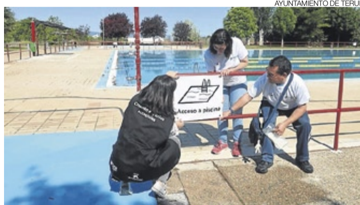
▶▶ Los operarios colocan señalización junto a los vasos de las piscinas.
