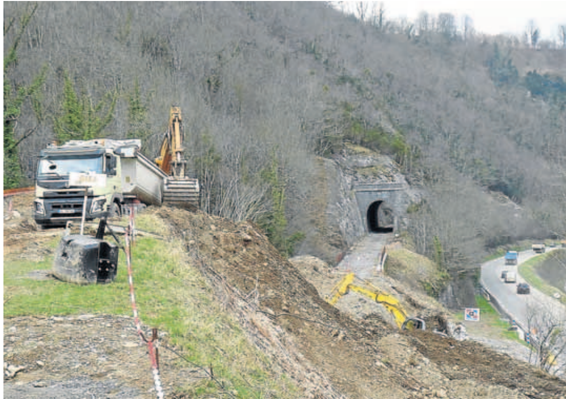
Trabajos en el tramo próximo a Bedous, en el desvío a Lourdios-Ichère, para evitar taludes. LAURA ZAMBORAÍN
