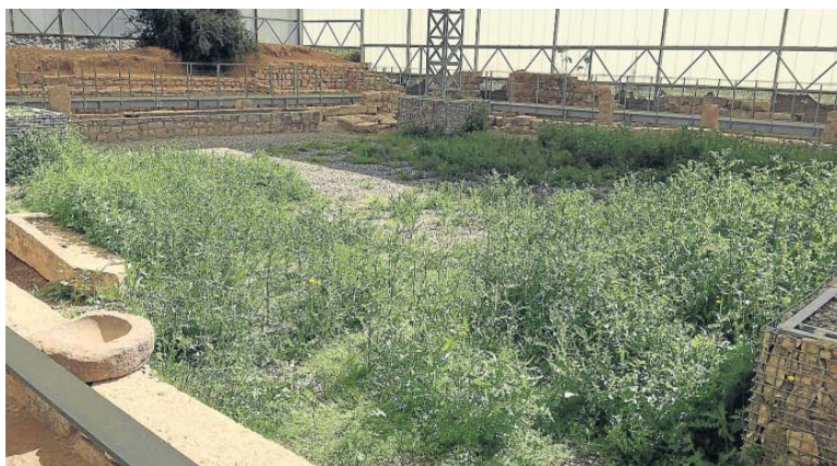
La maleza se adueña del yacimiento, cuya cubierta está repleta de goteras. RAQUEL DE LA PINTA
